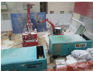
Atelier de forage micropieux
