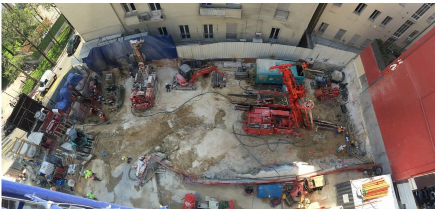
Vue aérienne du chantier
